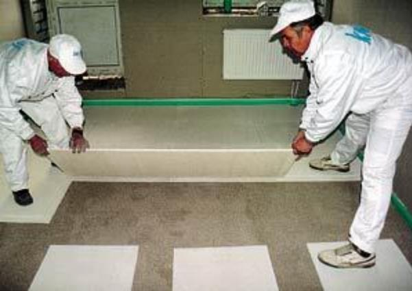
уступает по прочности ДВП. Я провел <полевые испытания> и попробовал вбить в панель ГВЛ гвоздь. Вбил, но вынуть его смог, только повесив на него 40-килограммовый мешок с сухой смесью. Другой важный момент - ГВЛ превосходит по своей влагостойкости и гипсокартон, и панели из ДВП.
